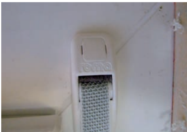
Abb 1.6: Eine luftdicht konstruierte Rollladengurtdurchführung (Foto: Erich Keller)
