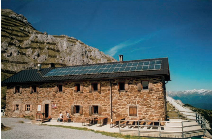
Abb. 1.10: ... eine Berghütte autark mit Strom zu versorgen. (Foto: SMA Technologie AG)
