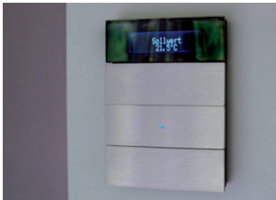
Abb. 2.8: Multifunktionstaster mit Raumtemperaturregler und Display – hier wird die gewünschte Temperatur auf Tastendruck verändert.
