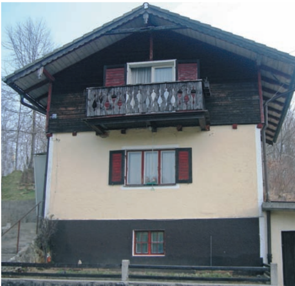
Abb. 1.4: Altbau aus den 20er-Jahren mit marodem Dachstuhl, feuchtem Keller, veralteter, korrodierter Elektro- und Sanitärinstallation, undichten Fensterrahmen mit Einfachverglasung und fehlendem Wärmeschutz. Abriss und Neubau sind geplant, da die Kosten für eine Sanierung die für einen vergleichbaren Neubau übersteigen würden.
