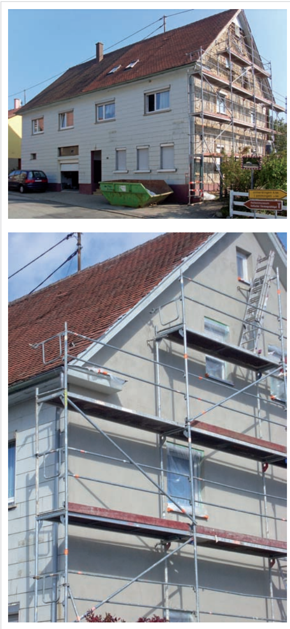
Abb. 1.1: Haus bei der energetischen Sanierung.
