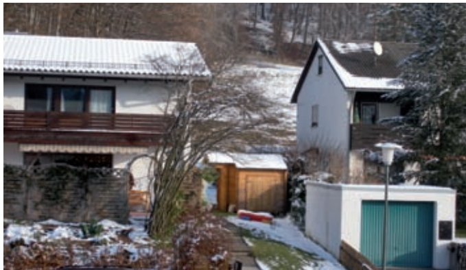
Abb 1.4: Ein klassisches Beispiel: Auf dem Hausdach links liegt eine durchgängige, etwa zehn Zentimeter dicke Schneeschicht, weil das Dach gut gedämmt ist. Der Schnee auf dem Dach des Hauses rechts dagegen ist wegen ungenügender Dämmung fast vollständig weggeschmolzen. (Foto: Reinhard Hoffmann)
