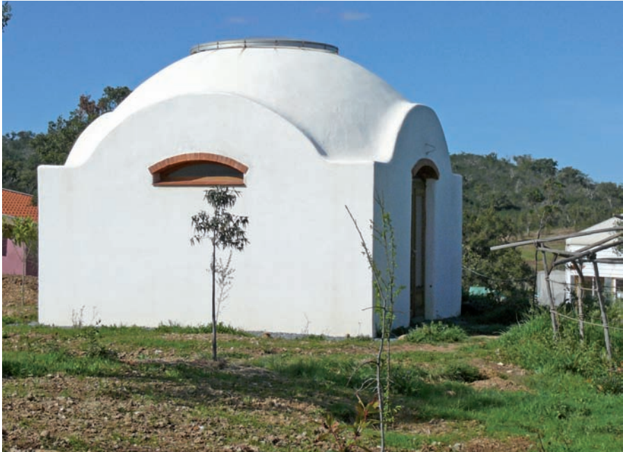
Abb. 1.6: Lehmbau mit dicker Wand und viel Speichermasse, wie er in heißen Regionen sinnvoll gebaut wird.
