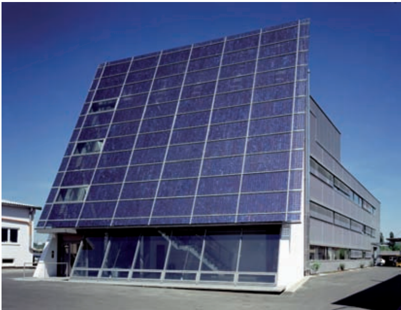
Abb. 1.8: Große Solarfassade eines Unternehmens. (Foto: SMA Technologie AG)
