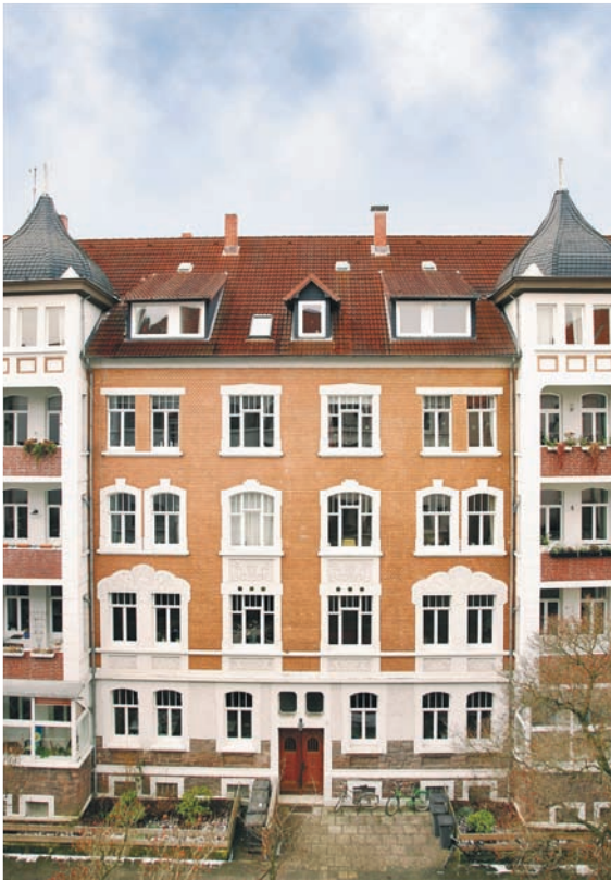
Abb. 1.5: Sanieretes Mehrfamilienhaus; viel Aufwand wurde betrieben, um die ursprüngliche Fassade zu erhalten. (Quelle: BHW Bausparkasse)
