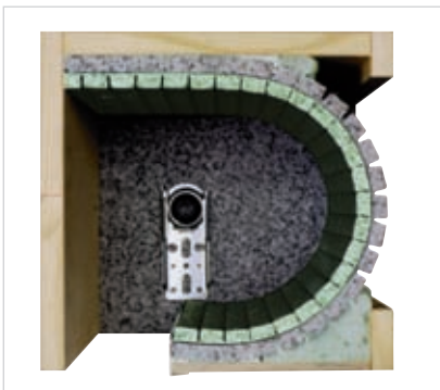
Abb 1.8: Rollladenkasten-Sanierungssystem zur nachträglichen Dämmung, das die Anforderungen der EnEV erfüllt (Foto: Beck + Heun)
