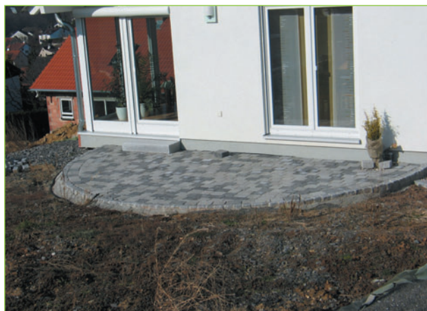
Abb. 1.3 – Achten Sie darauf, die Terrasse nicht zu klein zu planen und anzulegen. Gerade bei runden Formen ist eine ausreichende Größe wichtig.
