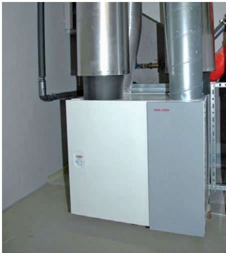
Abb. 2.9: Kontrollierte Raumlüftung mit Wärmerückgewinnung und KNX-Steuerung.
