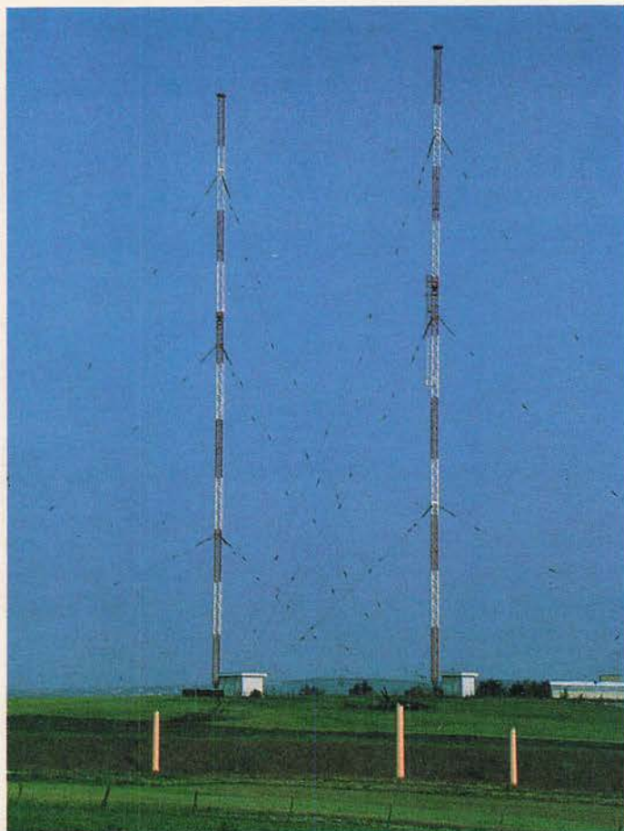
Bild 2: Unmoduliert produziert dieser Sender der Europawelle Saar 1200 kW an Ausgangsleistung auf 1422 kHz \pm 210,97-m-Wellenlänge. Die Gittermasten stellen eine in der Richtcharakteristik beeinflussbare Antennenform dar. Die metallenen Abspannungen sind deshalb von jeweils mehreren Isolatoren getrennt, damit sie nicht in Resonanz geraten und das Richtdiagramm der Antenne beeinflussen.
