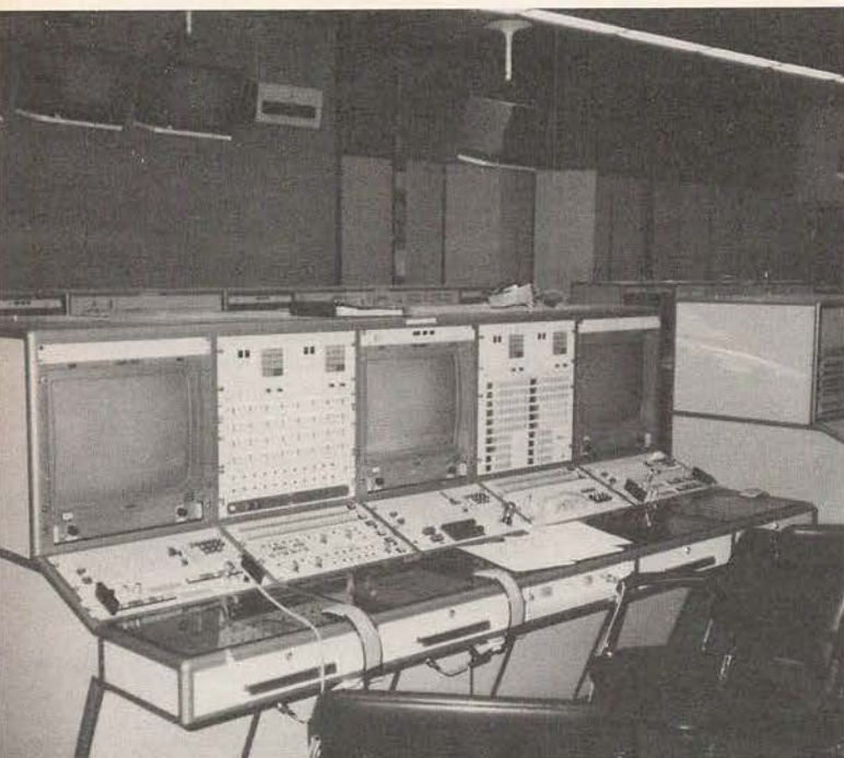
Bild 4: Eine der Konsolen im Launch Center, das mit zwei Meter starken Betonplatten gesichert ist, weil es sich in der Nähe der Startplattform befindet. Hier laufen alle Informationen von der Rakete und vom inzwischen montierten Satelliten während des Count Down zusammen – insgesamt ca. 5000 Meldungen und 400 analoge Meßwerte. Rechner und Bus-Leitungen sind vierfach vorhanden. Die insgesamt 18 Konsolen haben 600 digitale und 50 analoge Eingänge.
