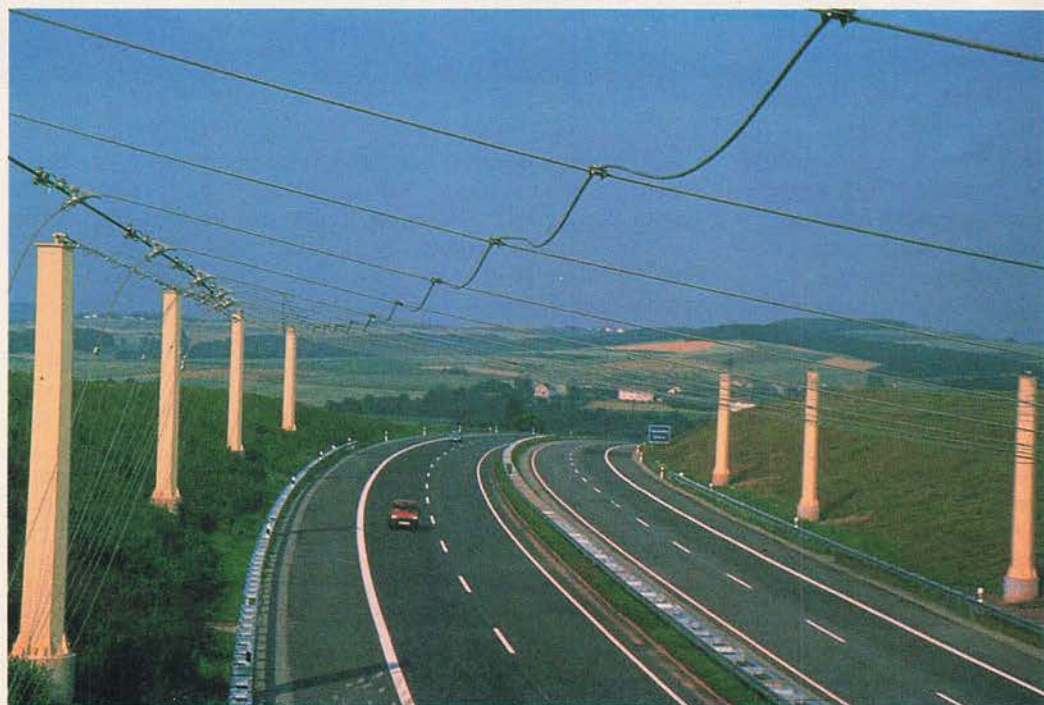
Bild 3: Die Stützen dieses „Abschirmgitters“ sind gut in Bild 2 zu erkennen. Hier das geschirmte Autobahn-A8-Teilstück bei Heusweiler.
