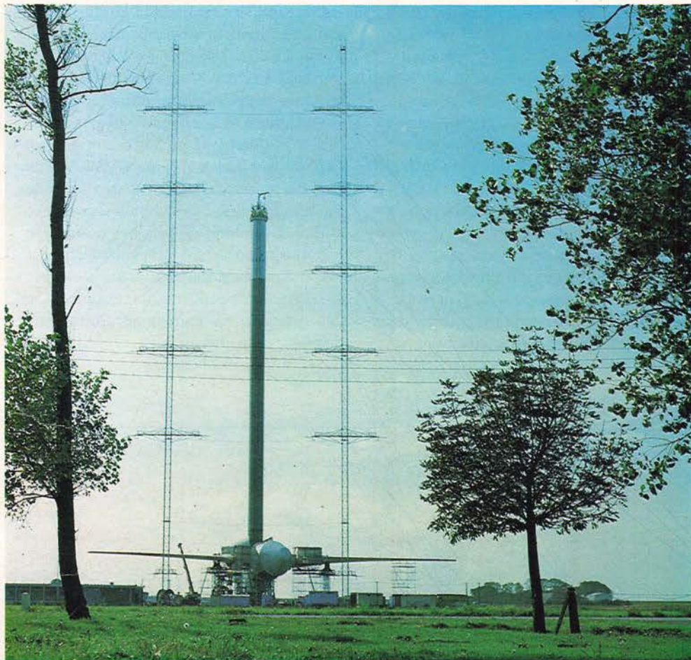
In wenigen Wochen wird das Maschinenhaus mit Seilwinden den Mast hochgezogen.
