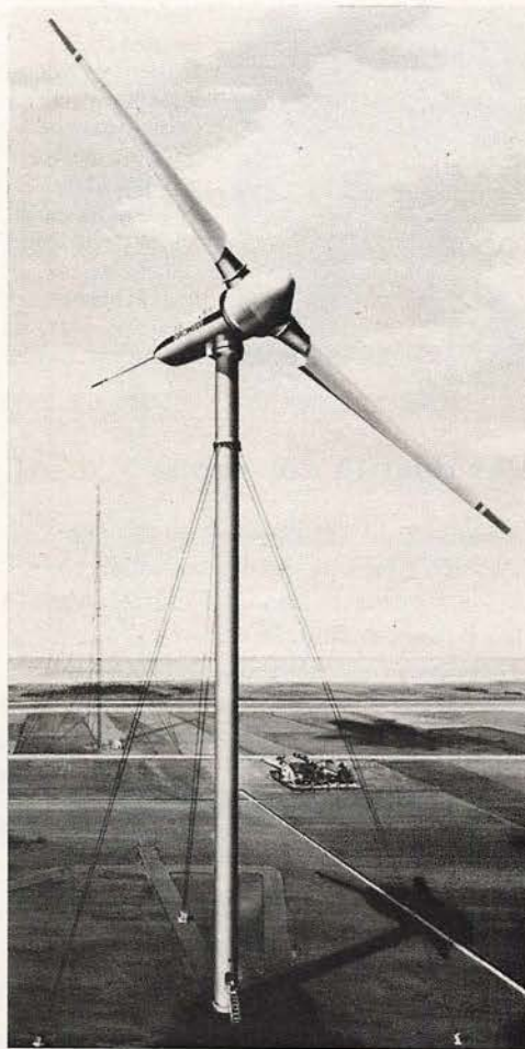
Eine Spannweite von 100 m haben die Rotorblätter, die sich auf dem fast 100 m hohen GROWIAN-Turm drehen (Phantombild).
