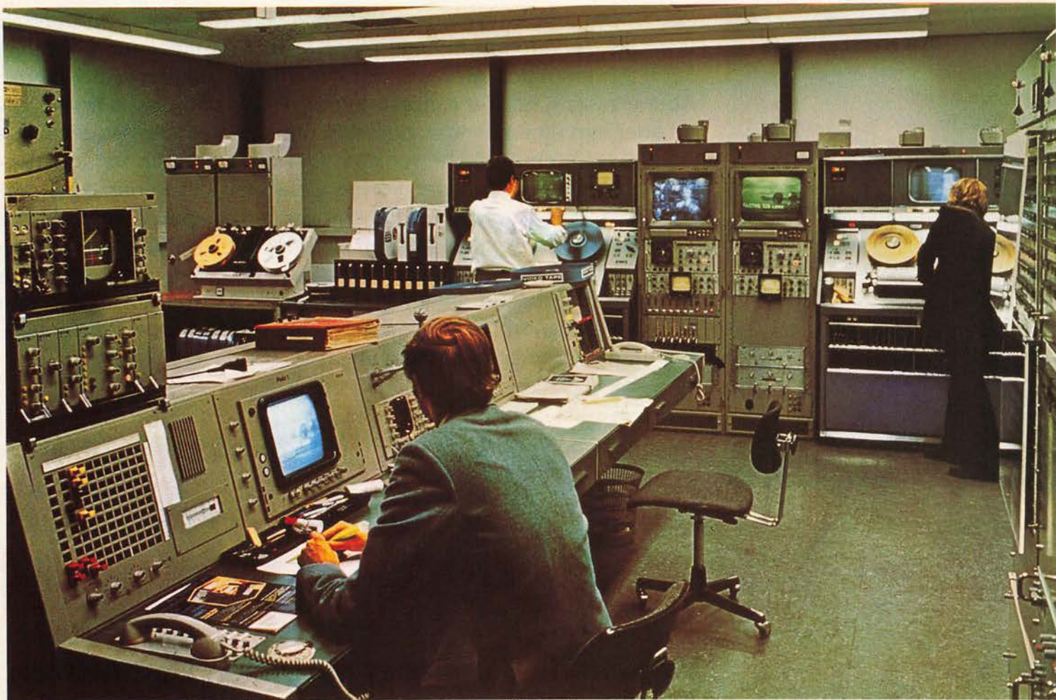
Im TV-Schaltraum wird bei Übertragungen alles überwacht und korrigiert, was auf der interkontinentalen Strecke schiefgehen könnte (Aufnahme: Manfred Gierig).
